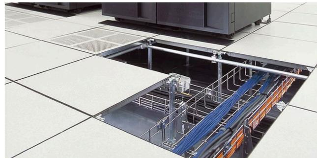
Ilustración 7: Funcionalidad del piso técnico
