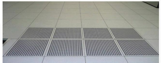
Ilustración 3: Sistema de piso técnico perforado
