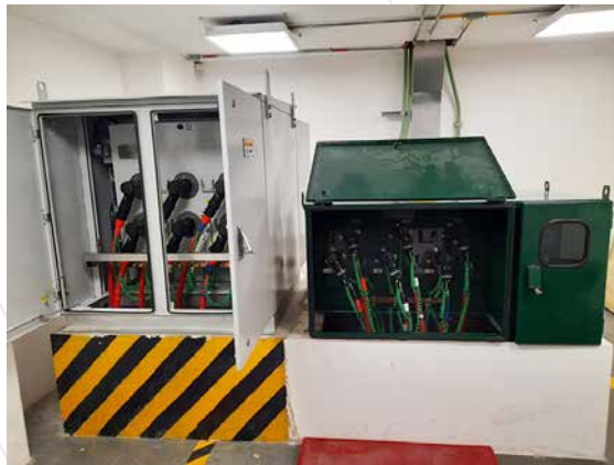
▲ NOJA Power GMK-1000 instalado en una subestación interior.
