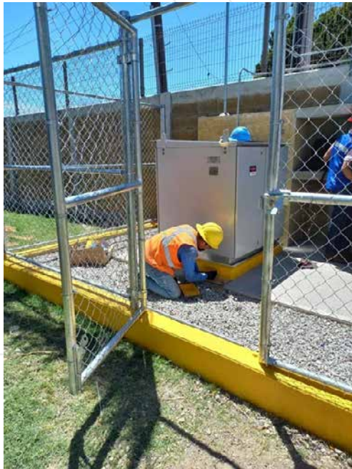
▲ NOJA Power GMK-1000 en una subestación exterior
