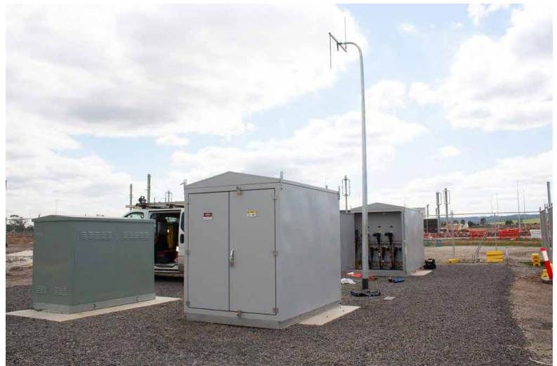
▲ Dos celdas GMK de NOJA Power conectadas en un esquema de transferencia automática
