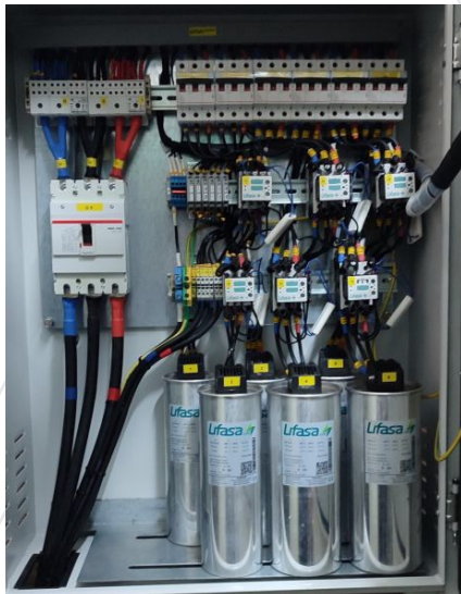
▲ Ilustración 1 Instalación del Tablero de Banco de Capacitores [125kVAr]
