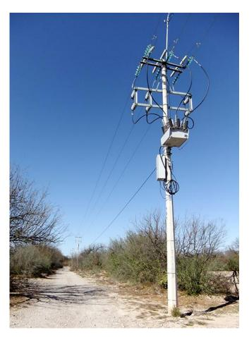
La implementación del localizador de falla realizada por de NOJA Power permite tanto el pronóstico local de la distancia a la falla en el panel de control, como el reporte remoto de los parámetros de falla. Este informe remoto de los parámetros de falla permite que el RC se integre en un sistema centralizado más complejo para el cálculo de la distancia a la falla. Una selección de las señales disponibles se presenta en la Tabla 1 a continuación.
