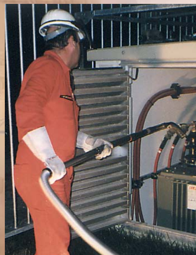
Durante la limpieza
